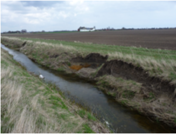
Tullstorpsån vid Sånarp före våtmarksanläggningen. Notera erosionen och ett mindre skred som tillför vattendraget sediment. Foto Johnny Carlsson
