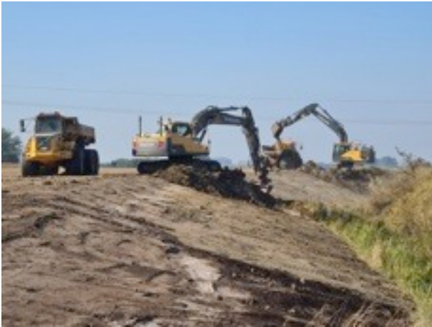
Grävarbete under etapp 2. Foto Johnny Carlsson
