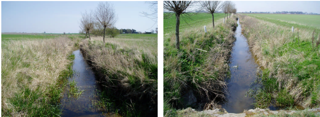
Bild 3-3 Bilden till vänster (t.v.) visar delsträcka 5 tagen från väst mot öst och bilden till höger visar delsträcka 6 tagen från öst mot väst (09.04.27).
