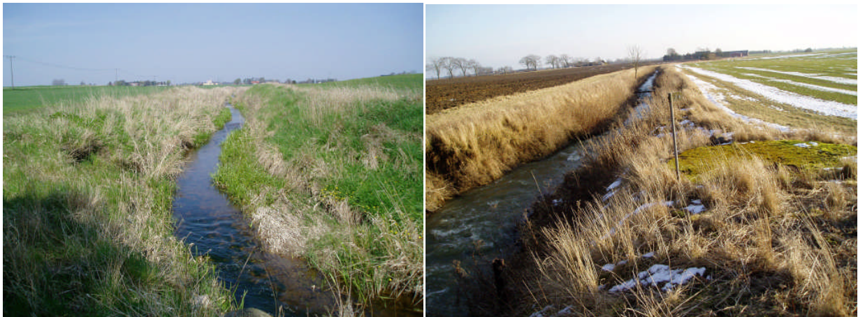
Bild 3-5 Bilden till vänster är tagen längre uppströms på delsträcka 8 (09.04.27) från söder mot norr. Bilden till höger är tagen på delsträcka 9 från norr mot söder, Källstorp by mot Stamåkra (09-02-24).
