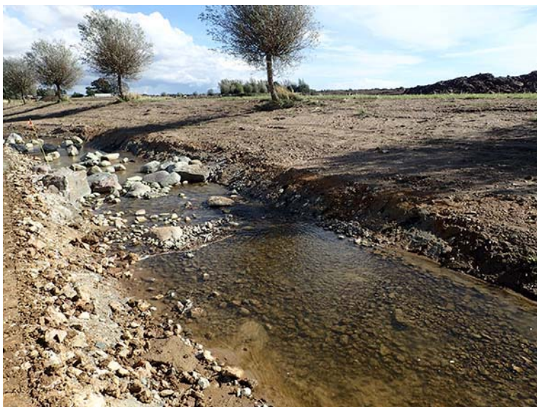
Foto 1. Sträcka nedströms Annexdal där sten och block material har placerats ut.
