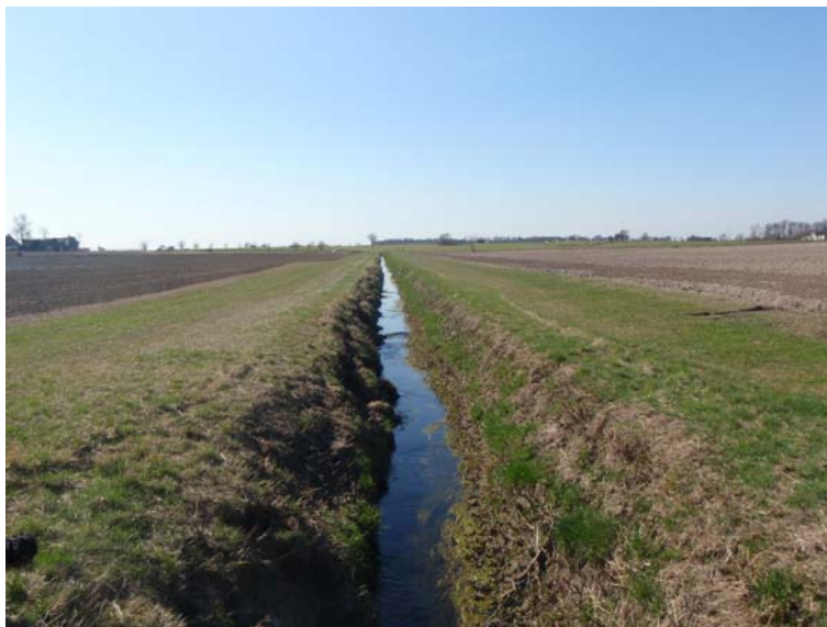
Foto 1. Vy över tillflödet St. Beddinge uppströms Framnäs (delsträcka 11).
