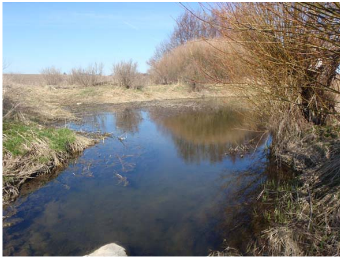
Foto 5. Befintlig slamfälla (delsträcka 5).
