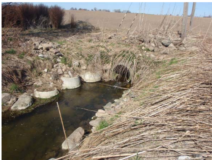
Foto 6. Kulvert längst upp på sträckan (delsträcka 5).
