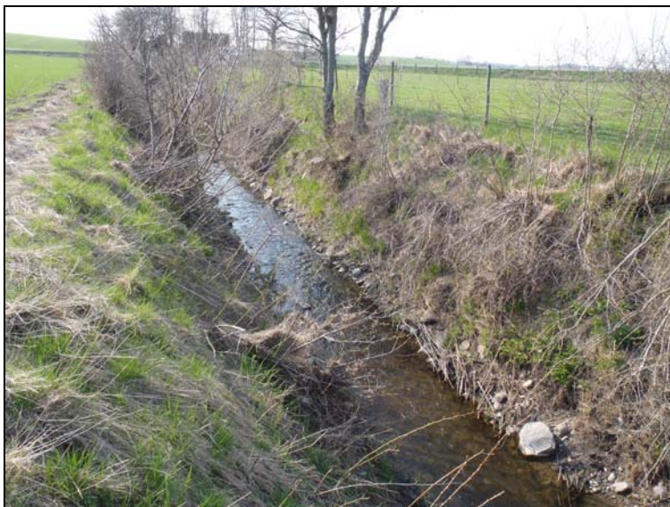
Foto 5.11 Sträcka 20, strömparti 100 m nedströms landsväg.
