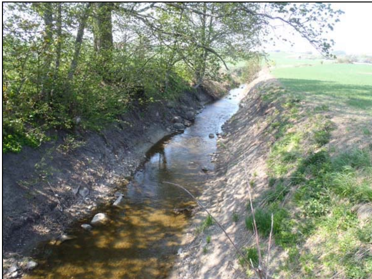
Foto 5.13 Sträcka 21, parti med hårbotten uppströms landsväg.
