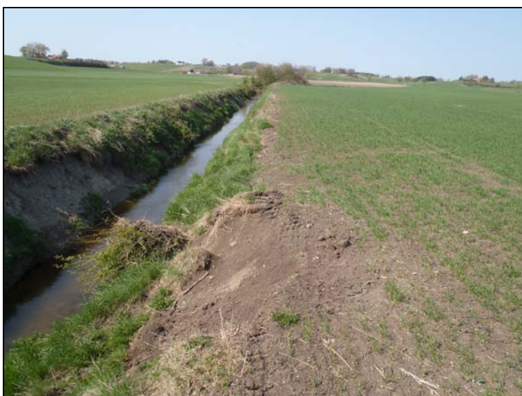
Foto 5.12 Sträcka 21, parti utan skyddszon och med erosion.
