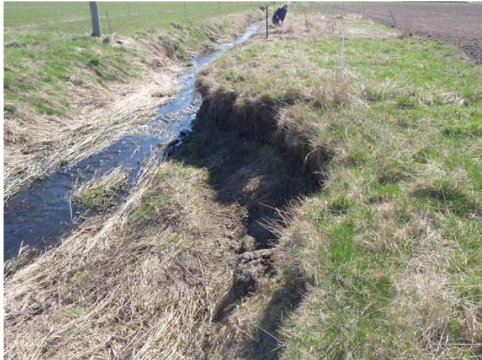
Foto 3. Parti med höga kanter och kraftig erosion (delsträcka 3).
