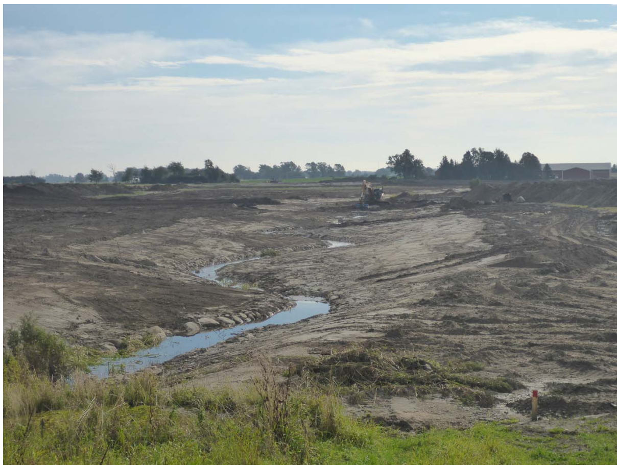
Foto 1. Grävarbeten i ån hösten 2015.
